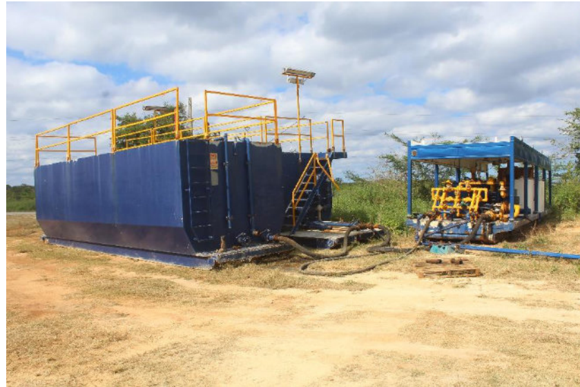
Fig. 4. Instalación para ensayo de carga e inyección de aguas producidas (Foto del autor)
